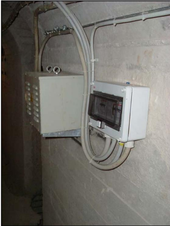
**Rifacimento dell' impianto di illuminazione e di forza motrice interna della diga secondo specifica tecnica fornita dall' Enel.**
